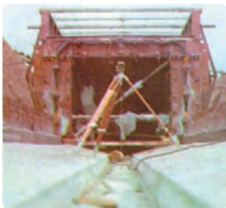
شکل ۳۰-۸- دوربین تراز یاب، سانتراژ با شاقول
