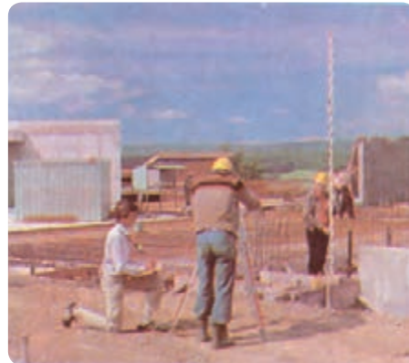
شکل ۱۴-۸- طریقه‌ی نگاه داشتن میر
